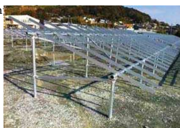
埋立後、単管打込式架台設置
