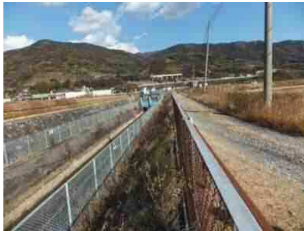
図 3-11 文命用水小水力発電実証の対象地点
