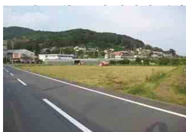
工事開始前の状態
