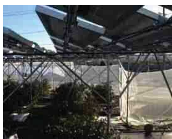
パイプ上に固定したパネル
