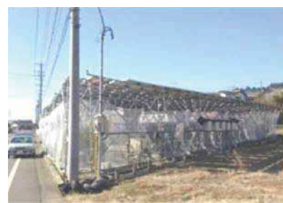
パワコン(10kW×5台)と系統連携
