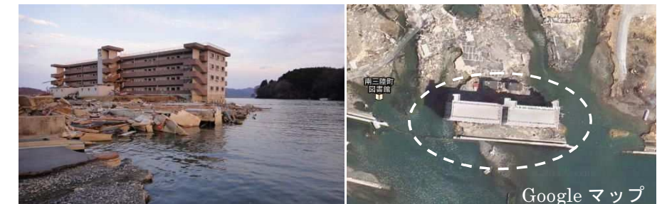
周辺は津波により浸水
