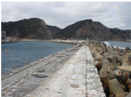
図-1 【波返工の被災状況】
